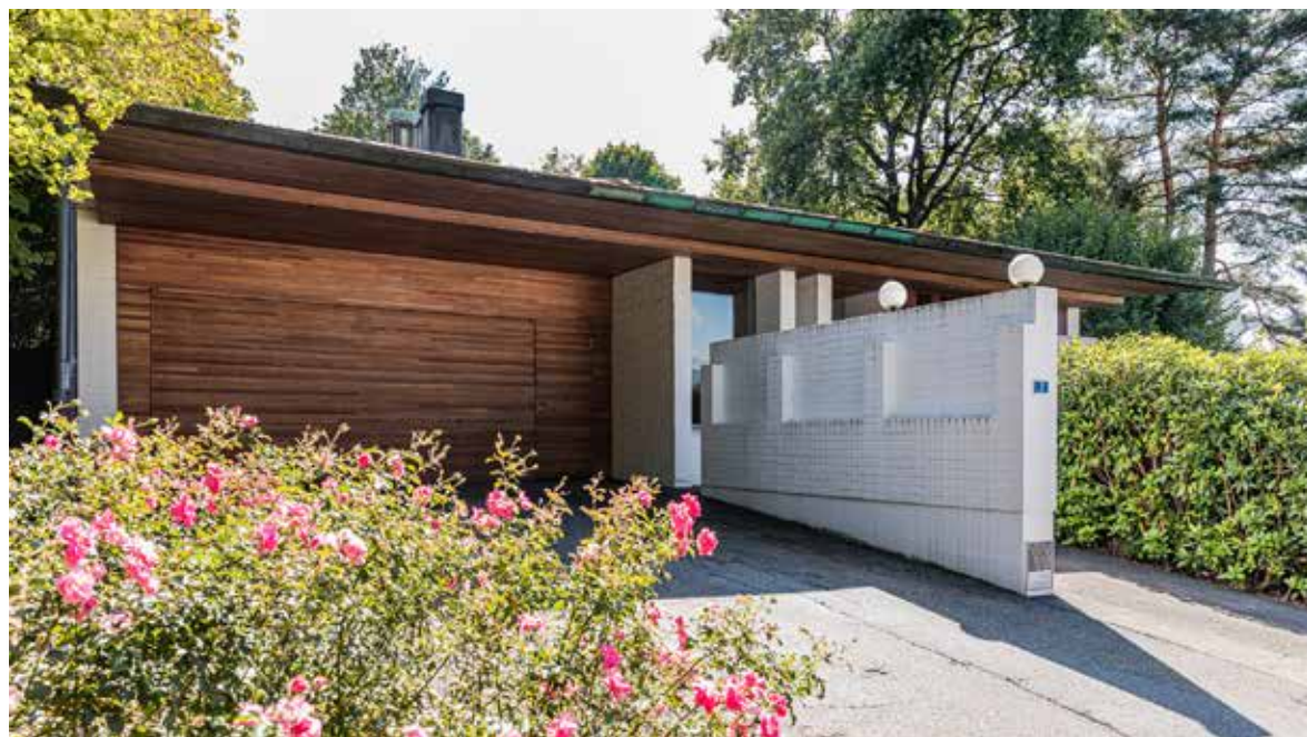
Harmonisch eingebettet in die Umgebung mit altem Baumbestand: Eingangsbereich des Hauses Kissling in Kappel SO. Foto Veronica Mayer
